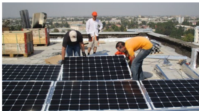
Installation der Anlage auf dem Dach der Tashkenter Staatlichen Technischen Universität „Abu Rayhan Beruni“. – Монтаж фотоэлектрической установки на крыше Ташкентского государственного технического университета «Абу Райхан Беруни».
