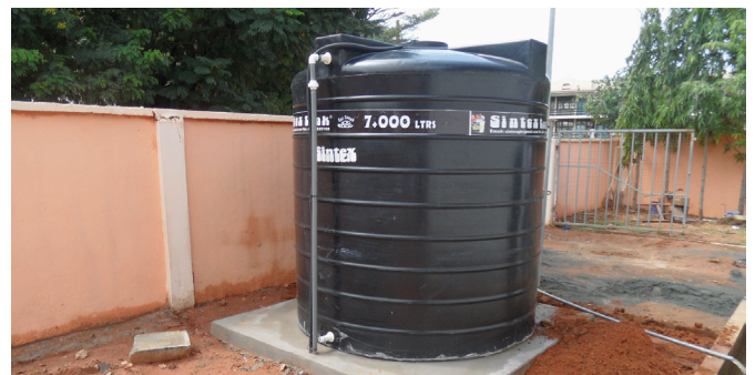
Solarpumpe mit Wassertank zur Warmwasserversorgung – Solar Pump and water tank for hot water supply
