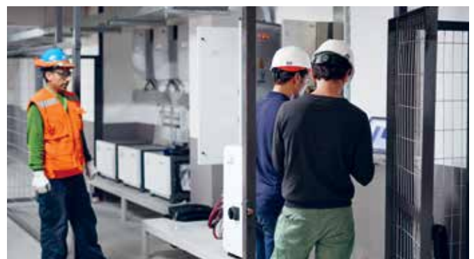
Mitarbeiter von GRAMMER Solar führen Tests mit dem Fernwartungssystem und den Batterien durch – Personal de GRAMMER Solar realizando pruebas con el sistema de gestión remota y baterías
