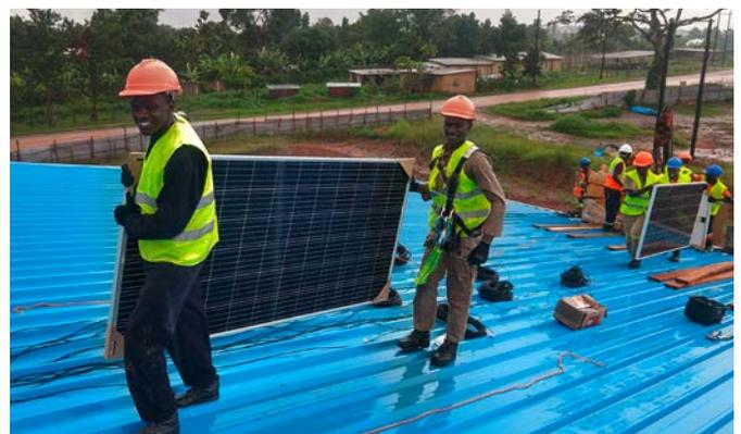
Lokale Arbeiter installieren die PV-Anlage auf dem Dach einer neuen Halle des Molkereibetriebs.
