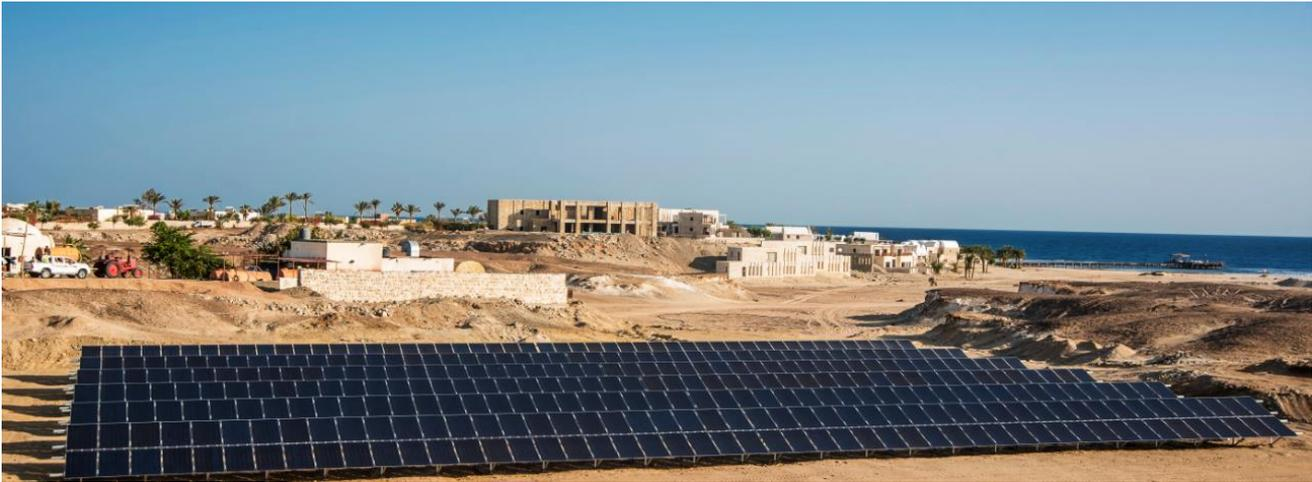
Abb. 24: Bild des im Jahr 2016 durch KarmSolar fertiggestellten 150 kWp Off-Grid Hybrid-PV-Systems für ein Tourismus-Resort in Marsa Alam. [Quelle: Bildmaterial von KarmSolar nach Interview der AHK am 07.06.2017 zur Verfügung gestellt]
