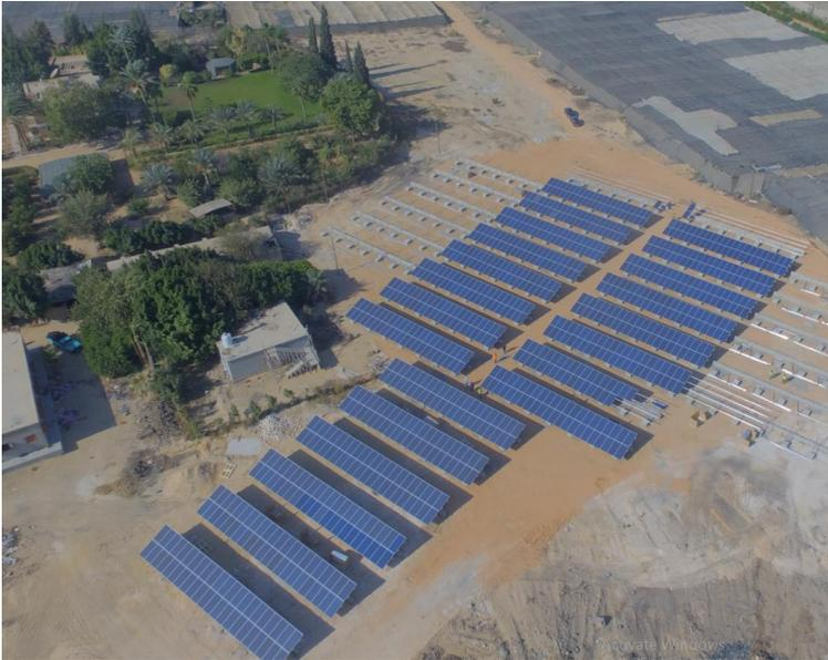
Abb. 26: Die 500 kWp-Anlage wurde durch SolarizEgypt für eine private Farm installiert (in Betrieb seit Dez. 2016)
