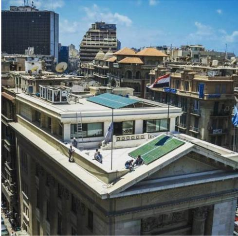
Abb. 33: PV-Anlage auf dem Dach der Alexandria Chamber of Commerce.
