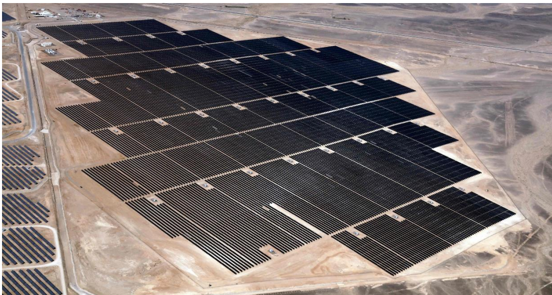
Abb. 15: Das Shams Ma'an-Projekt nach der Fertigstellung
