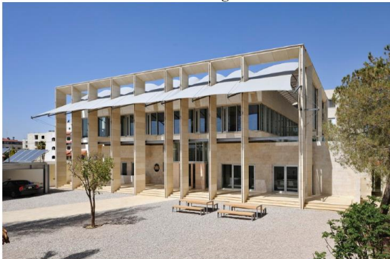
Abb. 22: Gebäude der Botschaft der Niederlande in Amman
