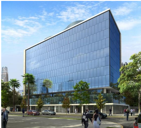
Edificio Bellet, Santiago de Chile 221
