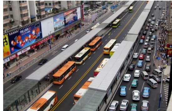
Abbildung 14: BRT-System in Guangzhou
