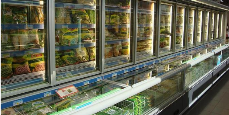
Abbildung 35: Energieeffiziente Kühlschränke mit automatischen Schiebetüren im AB Vassilopoulos Supermarkt Agios Dimitrios in Thessaloniki
