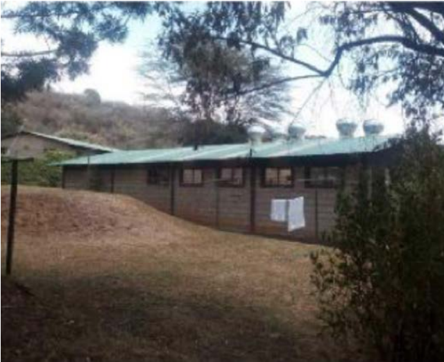
Abbildung 25: Dach der Wäscherei
