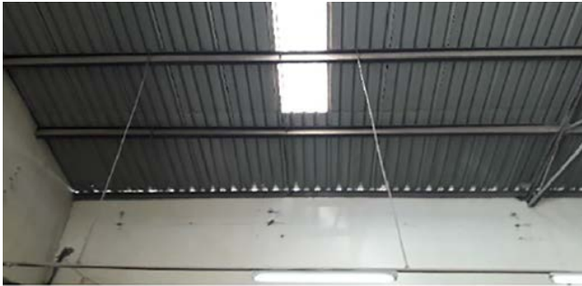
Abbildung 13: Dachkonstruktion des Standorts von Kip Melamine
