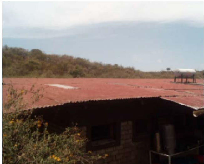
Abbildung 23: Hütte mit Dacheindeckung aus Teerpappe
