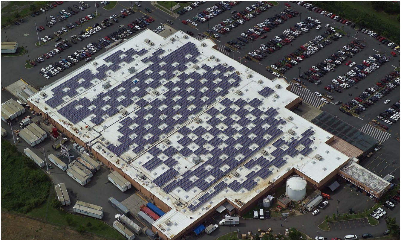
Abbildung 9: Solarzellen auf einem Walmart in Caguas, Puerto Rico
