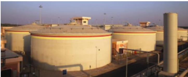
Abb. 17: Gärbehälter der Biogasanlage der Gabal El Asfar Kläranlage
