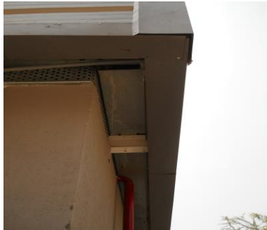
Verkleidete 100mm Dämmung an der Hauswand von Schmalz India (Quelle: AHK Indien 2017)
