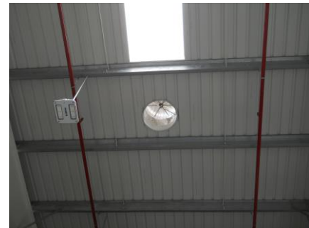
LED-Lampe, Lichtschacht und passiver Abluftventilator in der Produktionshalle von Schmalz India (Quelle: AHK Indien 2017)
