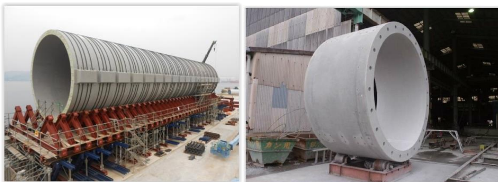
Abbildung 37: Spannbeton für Offshore-Anlagen; Quelle: Toda Corp.
