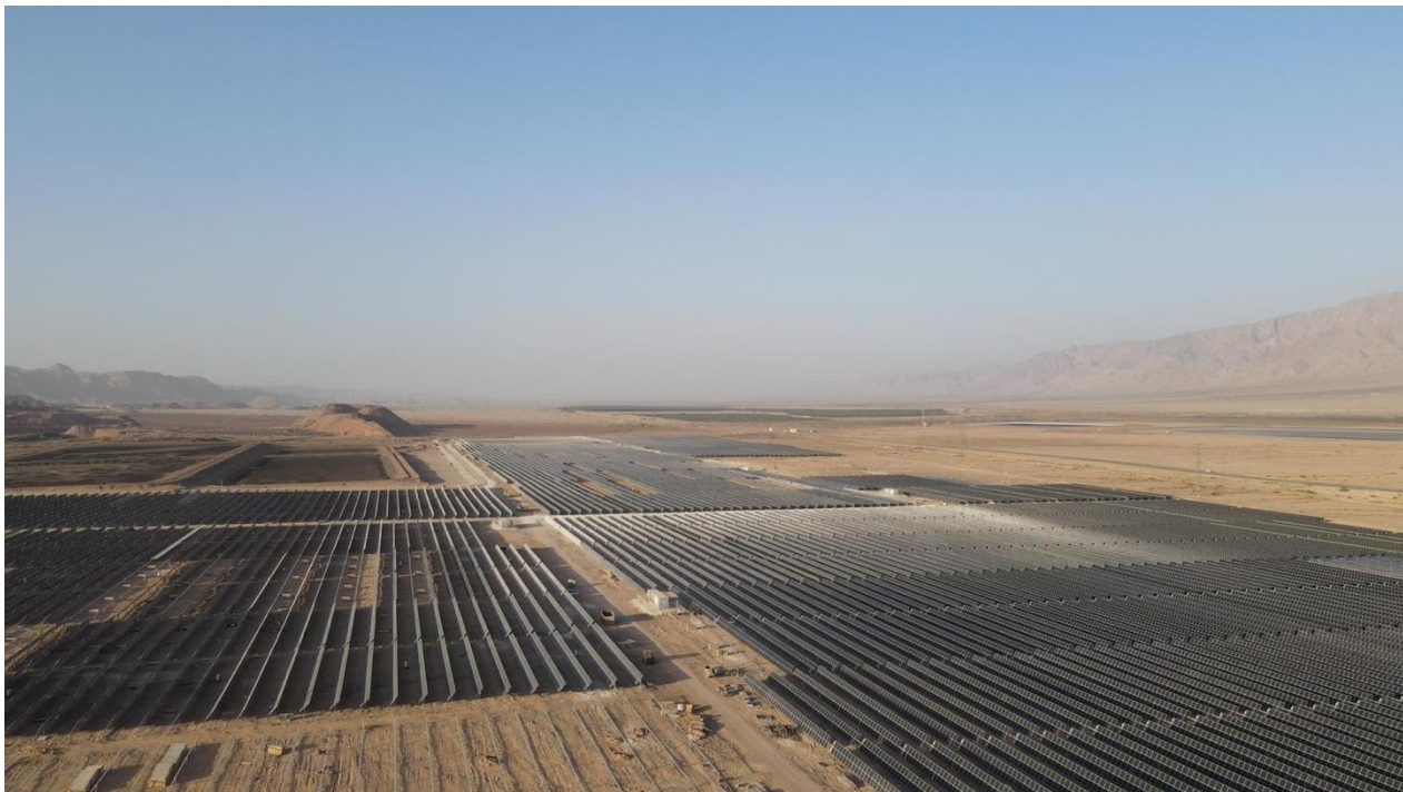
Abbildung 1: Fotovoltaikfeld im ariden Landessüden, hier PV-Feld in der Bauphase, Timna Oktober 2020 Quelle: EDF
