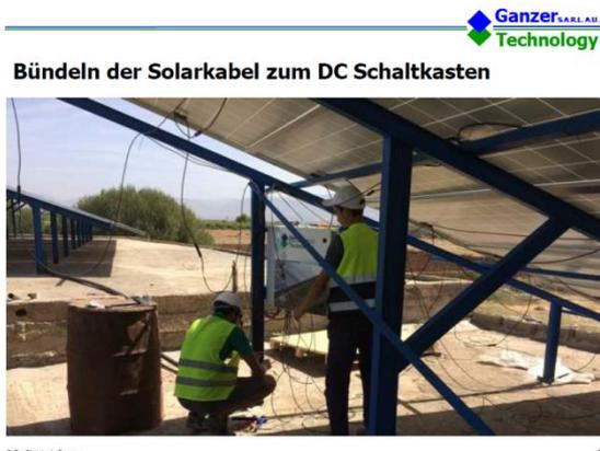
**Abbildung 3: Bündeln der Solarkabel**
