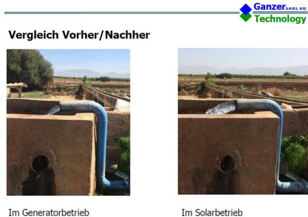
**Abbildung 4: Wasserpumpe**
