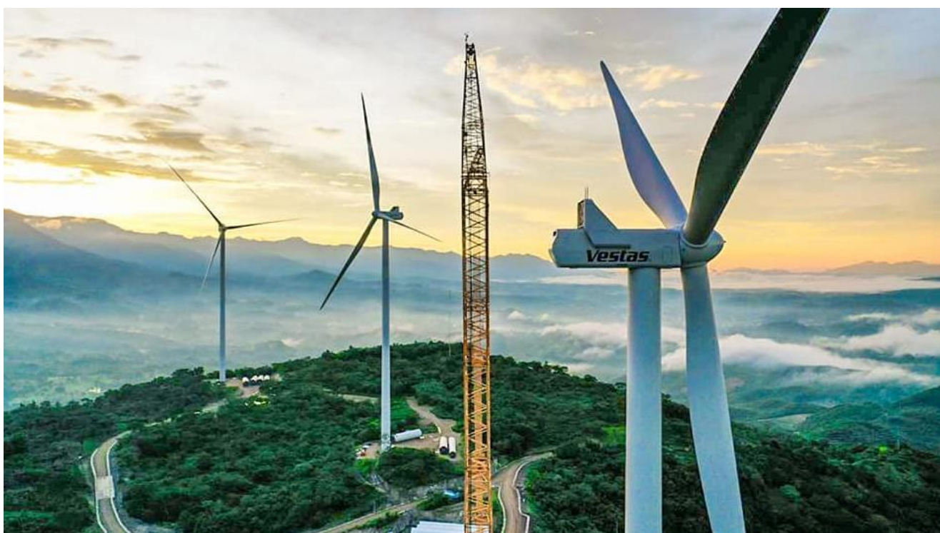
Abbildung 1: Windpark Ventus, 54 MW in Metapán
