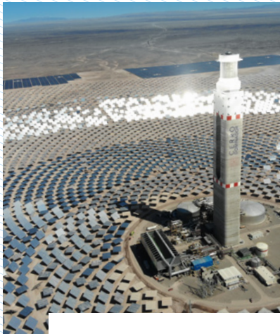
Solarturm (CERRO DOMINADOR)
