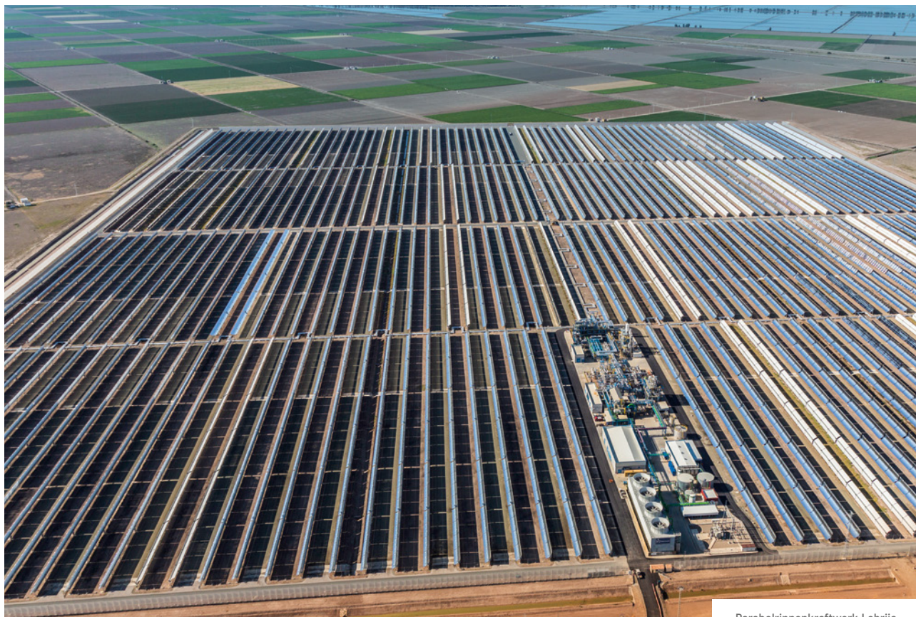
Parabolinnenkraftwerk Lebrija, Spanien (SIEMENS, 2012)
