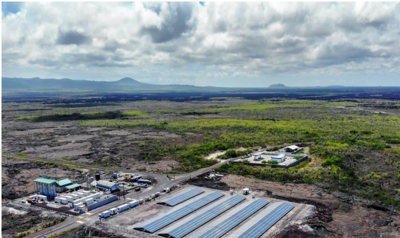
Abbildung 6: Erneuerbare Energien Galapagos, Quelle: Siemens-Erneuerbare Energien auf Galapagos
