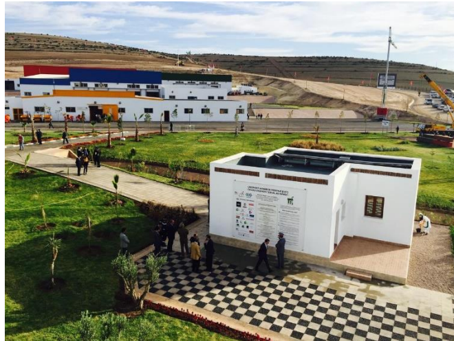
Abbildung 2: LEP Sozialwohnungsbau mit positiver Energiebilanz Quelle: Construction 21
