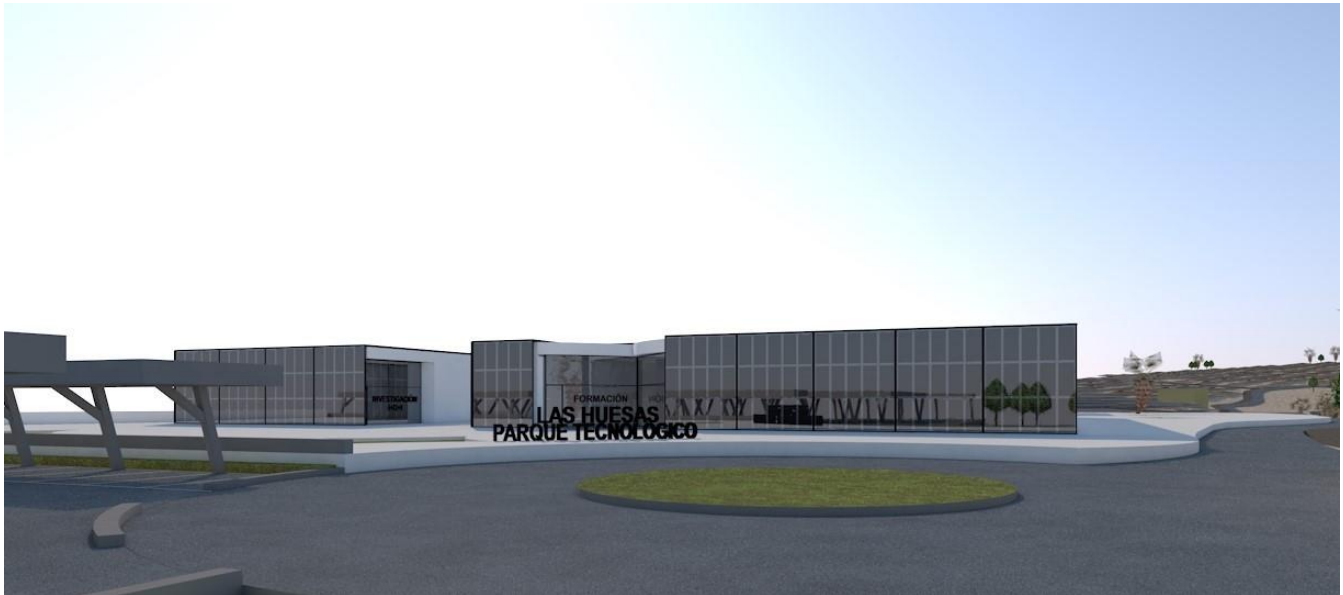
Abbildung 1: Technologiepark “Parque Tecnológico Energía Solar de Gran Canaria“
