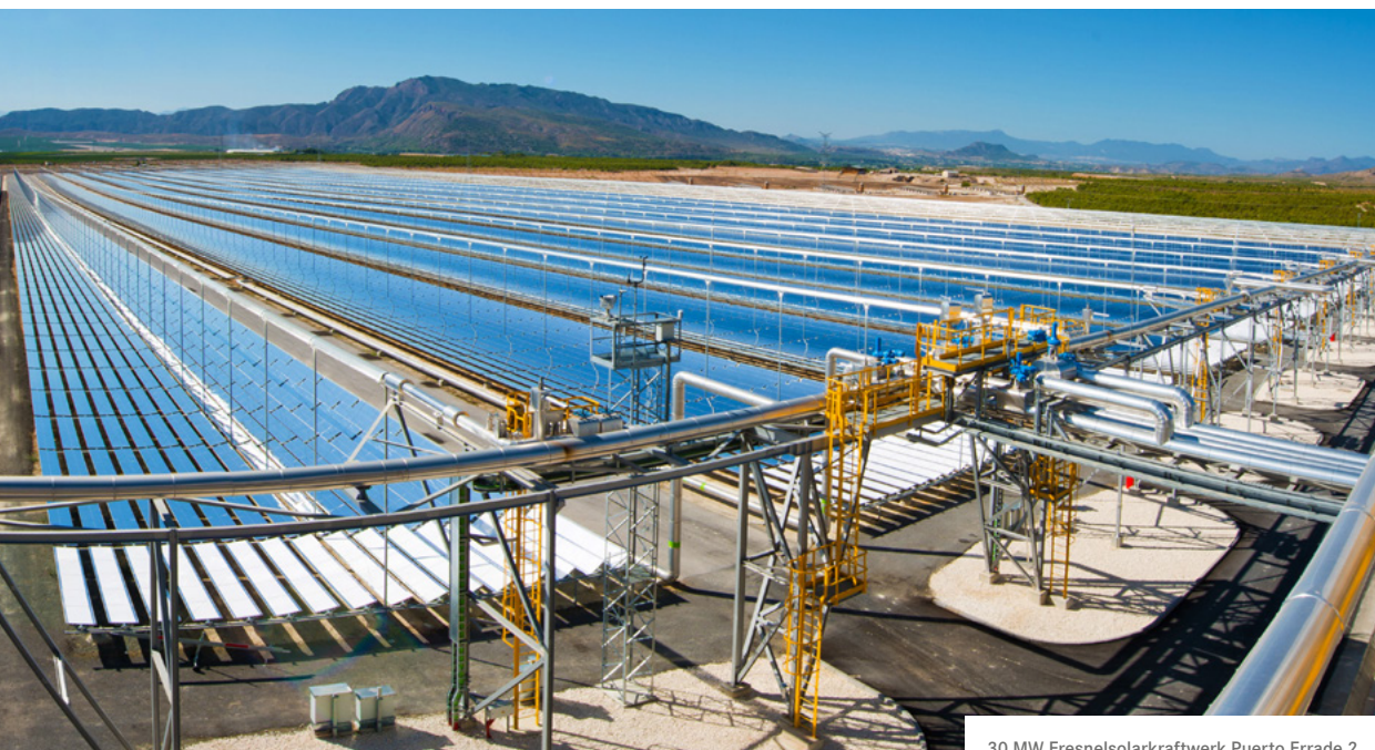
30 MW Fresnel-Solar-Kraftwerk Puerto Errade 2, Calasparra, Spanien (FRENELL GMBH)
