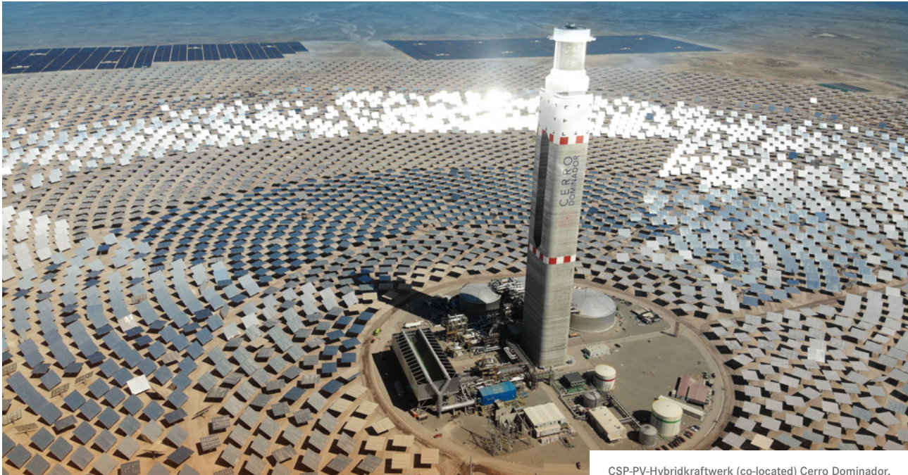
CSP-PV-Hybridkraftwerk (co-located) Cerro Dominador, Maria Elena, Chile (CERRO DOMINADOR)
