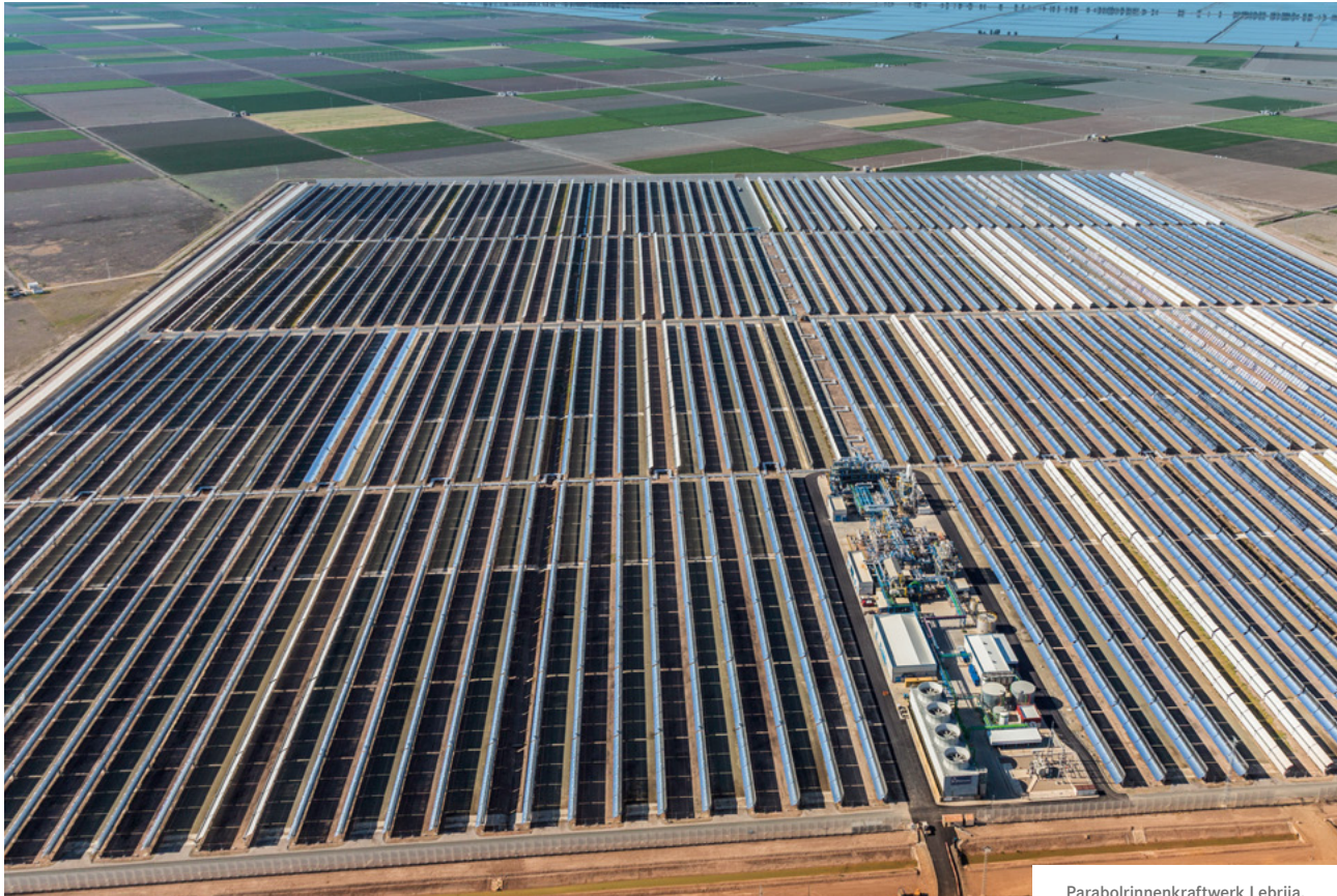
Parabolinnenkraftwerk Lebrija, Spanien (SIEMENS, 2012)
