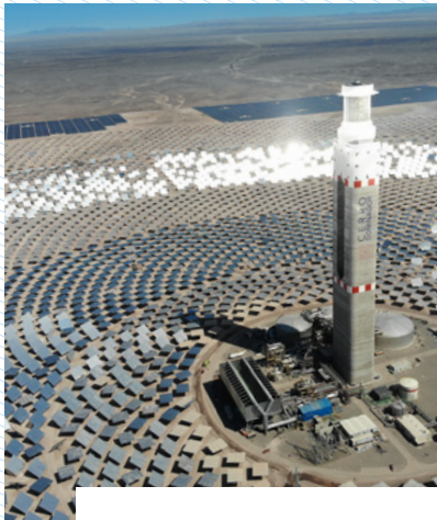
Solarturm (CERRO DOMINADOR)
